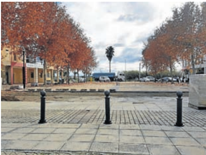
Una de las zonas donde se están ejecutando las obras. / El Correo
